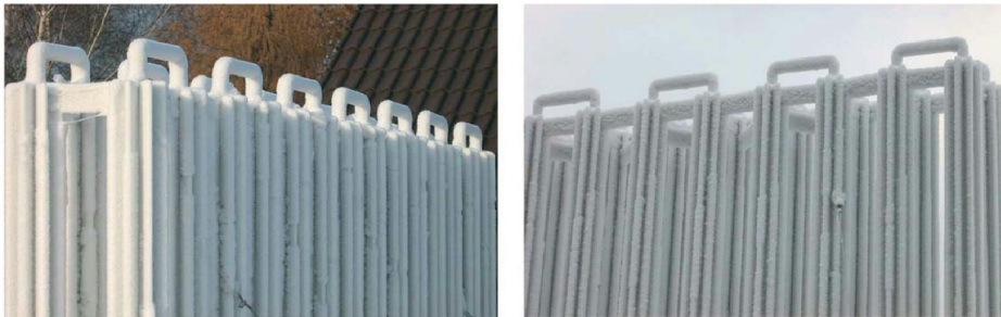
Rys. 2.3 Parownik prototypowy pompy ciepła EKO-HEAT podczas pracy
